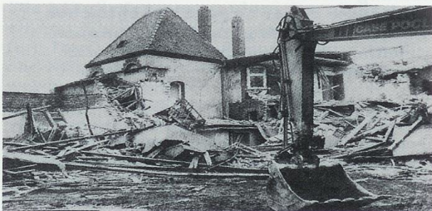
Die Abrißarbeiten an der Zentralhalle haben gestern abend kurz nach 18 Uhr begonnen. Sie sollen in etwa zwei Wochen beendet sein. Foto: Pfändler
