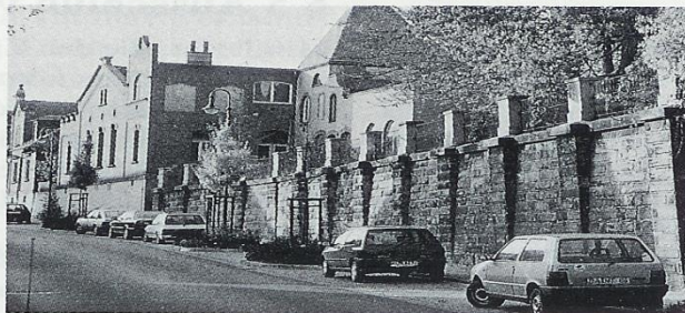
Das Tauziehen um die Zukunft der Zentralhalle geht weiter. Eine Sanierung des Gebäudes würde nach vorsichtigen Schätzungen rund zwei Millionen Schätzungen kosten. Foto: Tritschel
