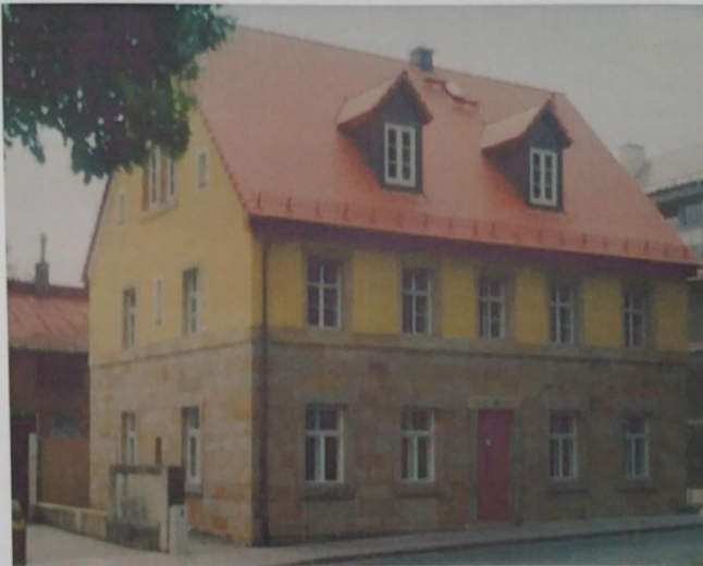
Geburtshaus von Wilhelm Leuschner (geboren 15. Juni 1890) Moritzhöfen 25, Bayreuth - errichtet 1878, renoviert 2001 -
